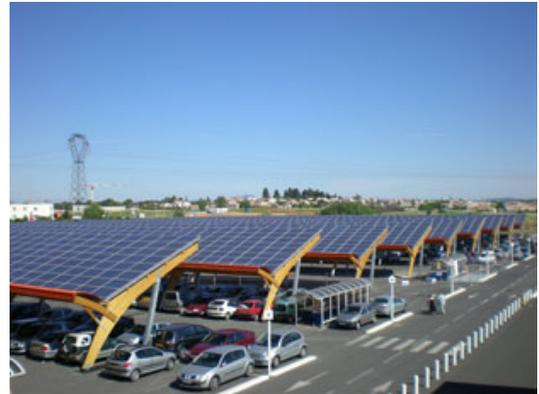
Figure 3 : parking équipé de panneaux PV en ombrière
