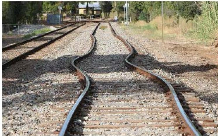
Figure 1: Déformation de rails lors de la canicule de 2003 sur la ligne de RER D
